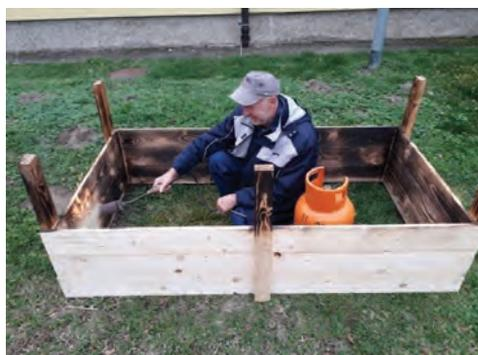
10. Zaštićenu gredicu potrebno je fiksirati u zemlju. Za to su nam potrebne rupe koje trebamo iskopati. Budući da naša gredica ima 6 štafli /nogu koje treba fiksirati u zemlju, potrebno je iskopati 6 rupa. Potrebno je izmjeriti međusobnu udaljenost štafli. Istu udaljenost potrebno je označiti na izabranoj površini. Kada smo označili mjesta za rupe, počinjemo iskopavati. Udaljenost rupa je 1 metar. Za ovaj posao potrebni su nam ašov i lopata.
